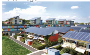
Solarsiedlung am Schlierberg Germany Arch. : Rolf Disch SolarArchitektur, Freiburg
