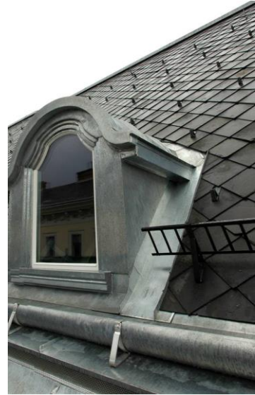
Figure 14: Klostergebäude Kaiserstraße, roofing with original slate tiles
